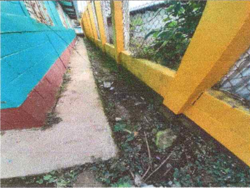
Foto1: Reparación de cuneta de concreto
