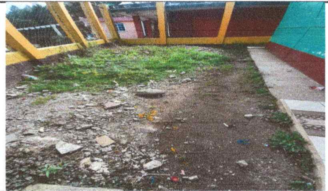
Foto 4: Sustitución de caja de registro
