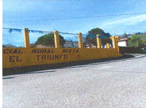
Foto 2: Sustitución de barandas de metal
